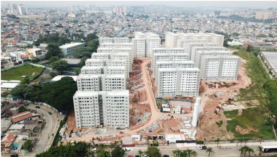
TÉRMINO DE ESTRUTURA – JANEIRO 26 (+12M) 25 TORRES- 2.000 UNIDADES
