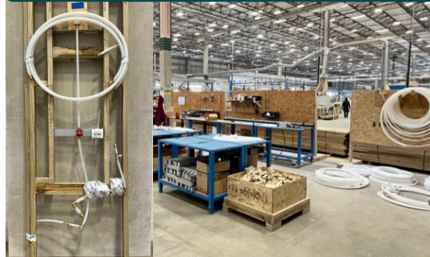
2. Estação de shaft e kit hidráulico
