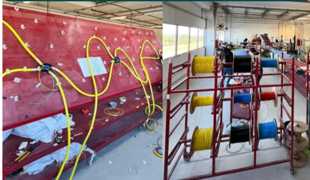
1. Estação de chicote elétrico
