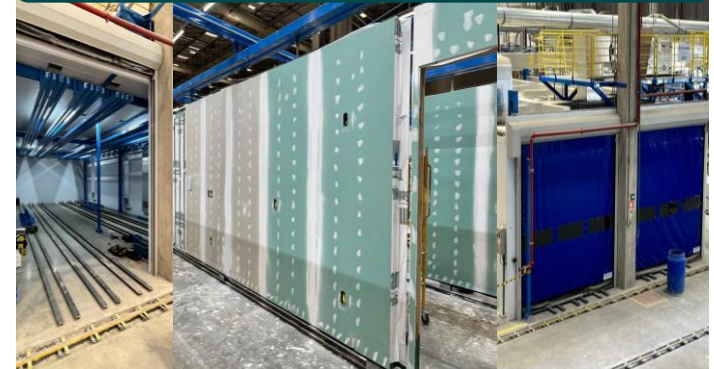
3. Estação de calafetação de painéis e câmara de secagem
