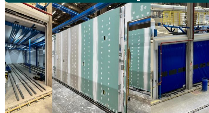
3. Estação de calafetação de painéis e câmara de secagem
