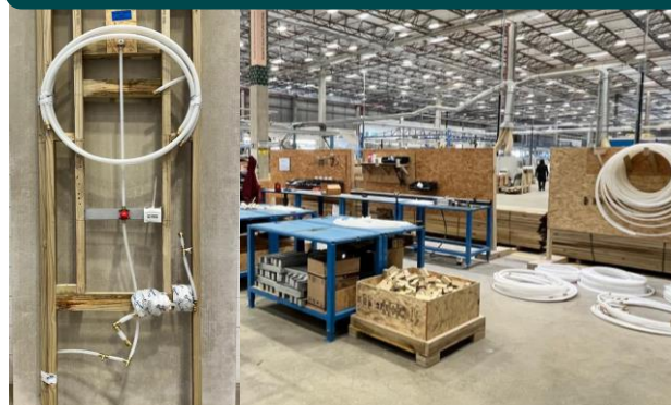
2. Estação de shaft e kit hidráulico
